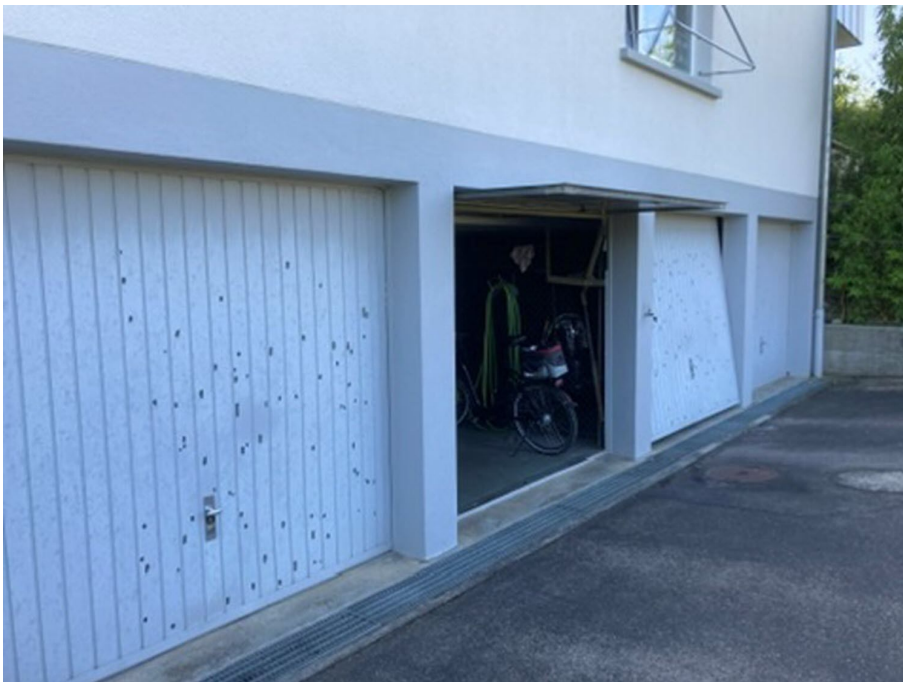
Kipptore vor Renovation
