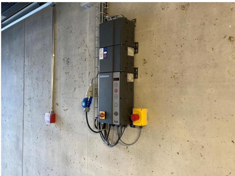
**Steuerung 560 für Kettenantrieb ITO**
