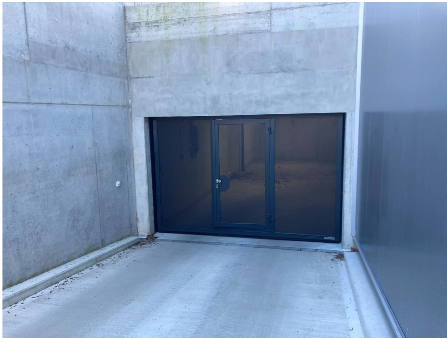
Einstellhallen-Kipptor ET500 mit Schlupftüre
