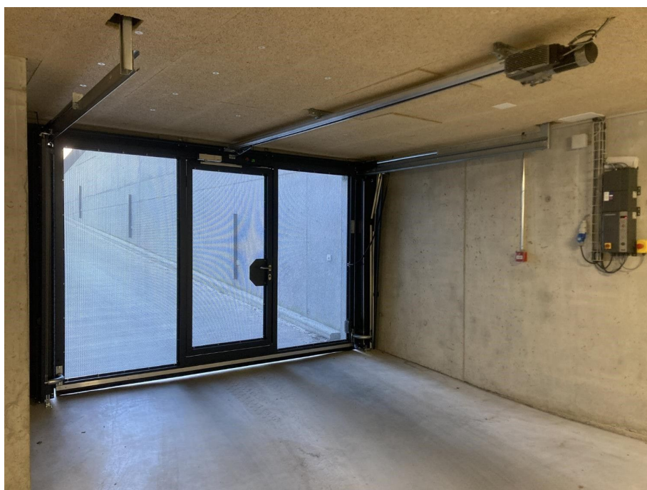
Einstellhallen-Kipptor ET500 mit Schlupftüre Innenansicht
